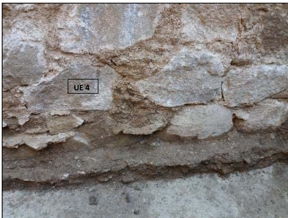
Fotografia 3. Detall i banqueta del mur UE 4, des de sud
