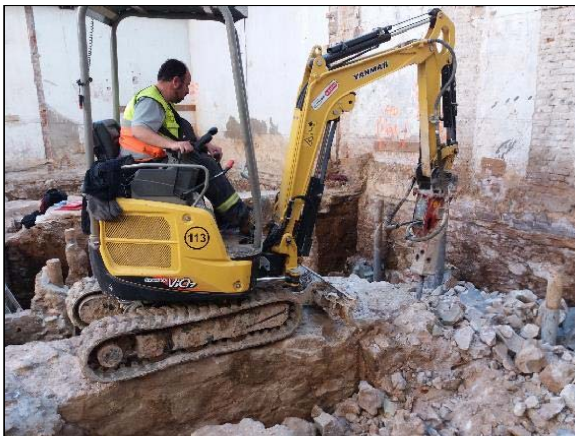
Fotografia 16. Desmuntatge estructures sector exterior
