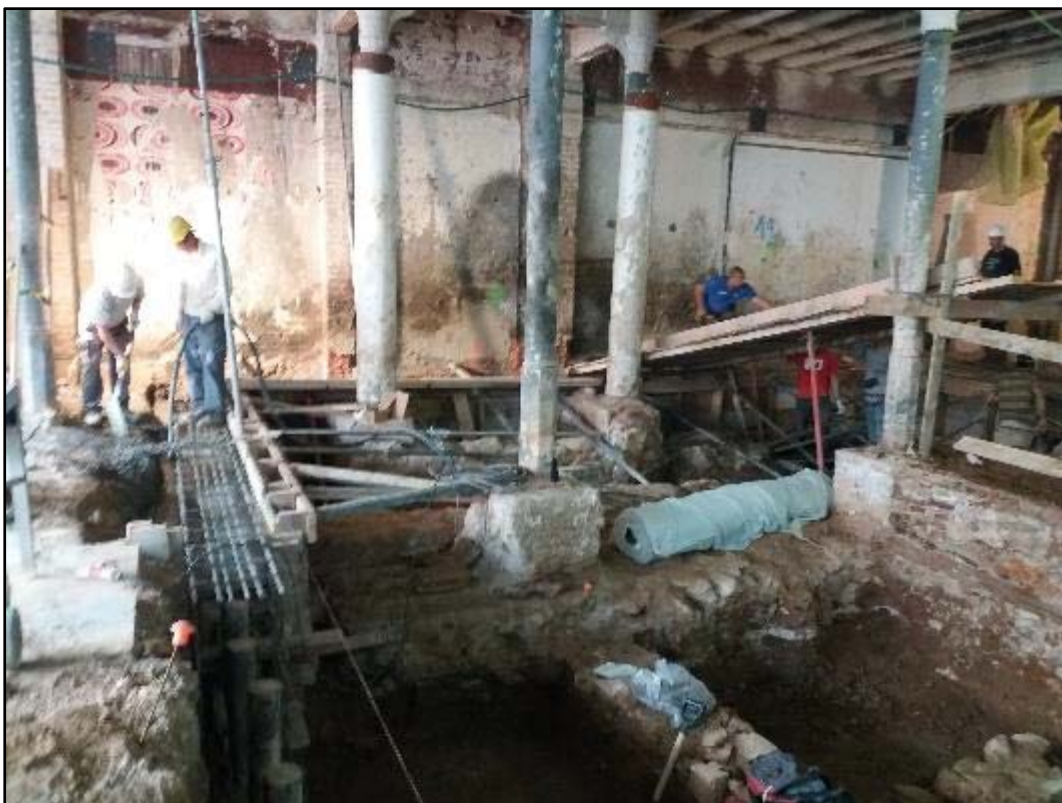
Fotografia 73. Treballs de l'obra
