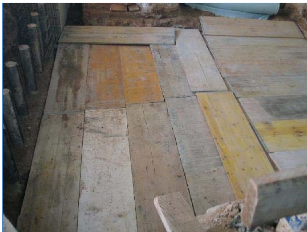
Fotografia 72. Estructures cobertes zona 3
