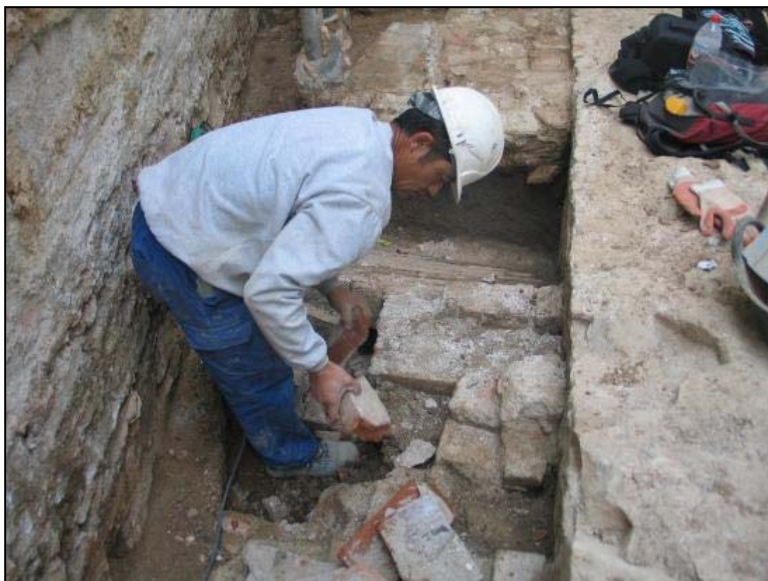
Fotografia 18. Desmuntatge claveguera UE 21, des de l'est
