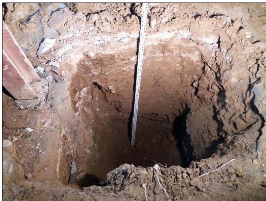
Fotografia 80. Pou per filtrar l'aigua dels micropilotatges
